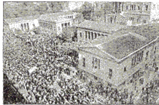
Φοιτητές και δάκτορες του Π.Μ.Ε. κατά τη διάρκεια της εξέγερσης του Νοεμβρίου 1973. Τα κτίρια, από τον δεξιό άξονα, είναι η κεντρική αίθουσα, η αίθουσα των μαθημάτων, η αίθουσα των εργασιών και η αίθουσα των μαθημάτων.
